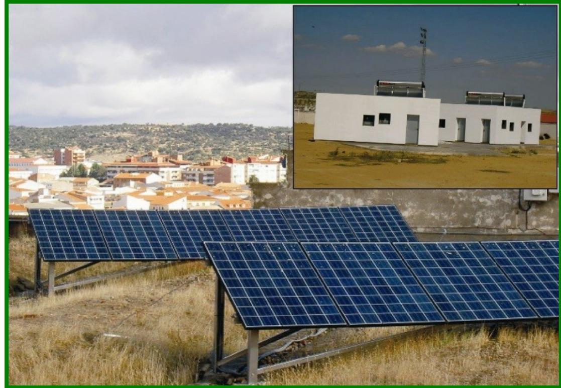
Instalación solar fotovoltaica 5kw e instalación solar térmica
