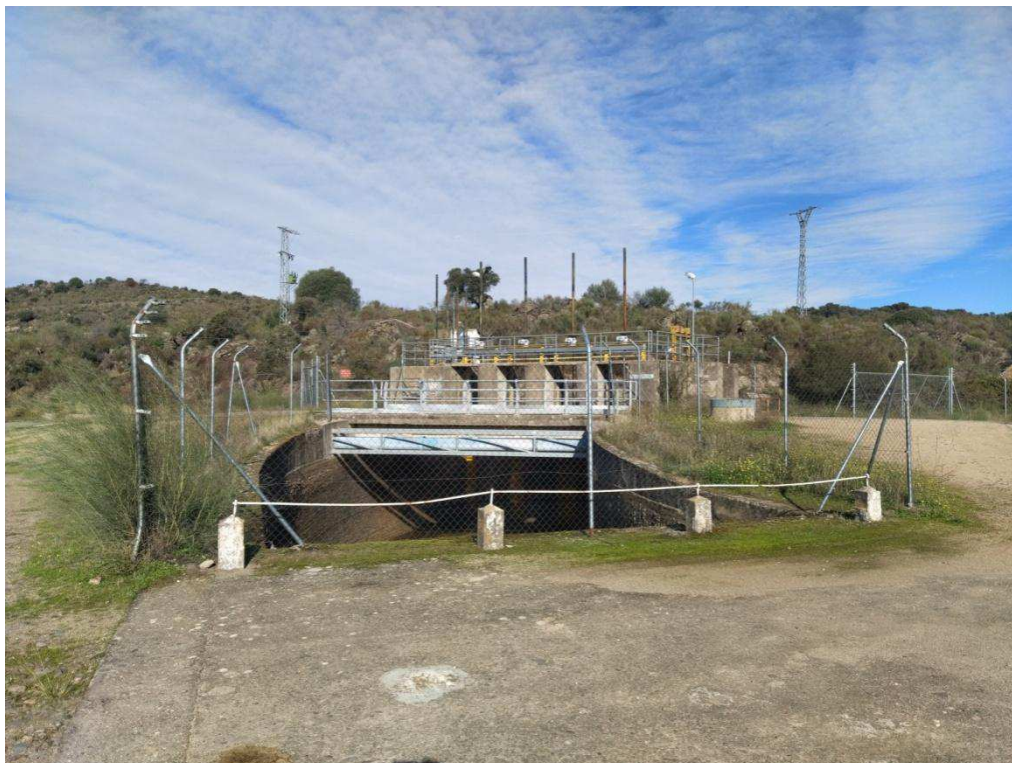
ACUEDUCTO SEPARACIÓN DE LAS DOS MARGENES. TÉRMINO MUNICIPAL DE VALDEOBISPO.
