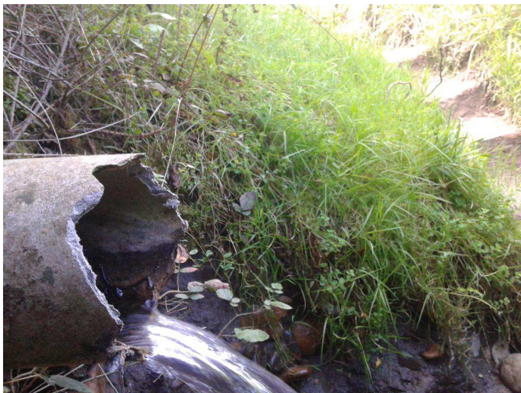
FUENTE DE USO HABITUAL. CAÑO DE FIBROCEMENTO. TÉRMINO MUNICIPAL DE RIOLOBOS.
